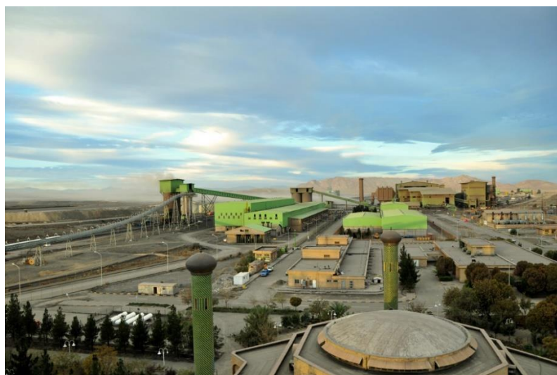
شکل (۲-۲): کارخانه پریارسازی سنگ آهن گل گهر.
