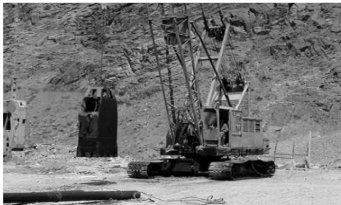
شکل ۲-۸، عملیات ترپان زنی سد شهریار میانه [چراغی، ۱۳۹۳]
