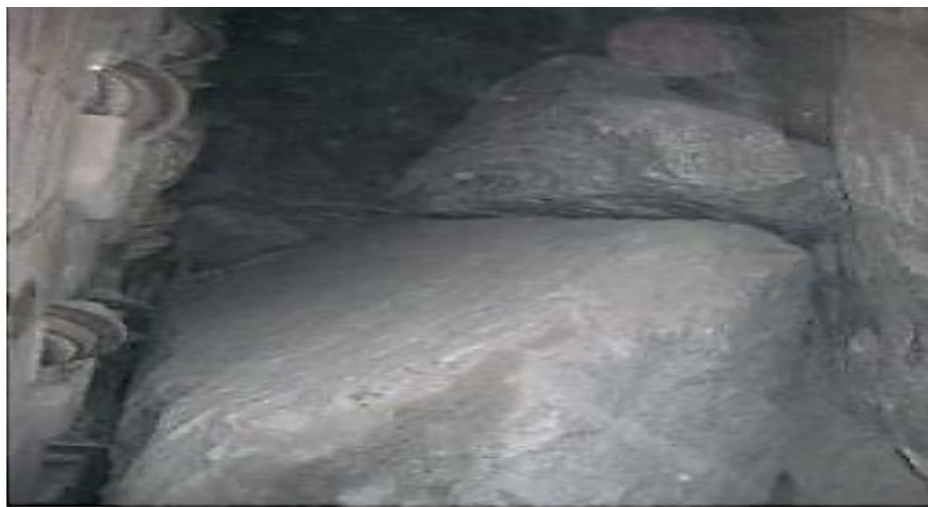
شکل ۴-۱: بلوک‌های بزرگ جدا شده از سینه‌کار تونل [۶۰]
