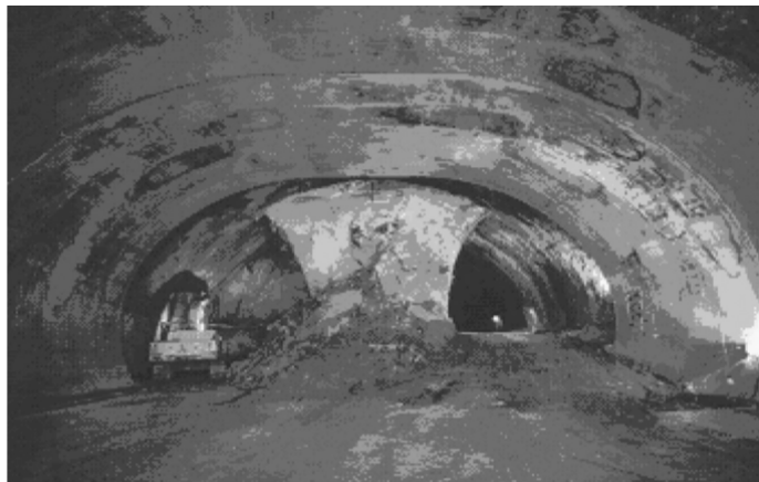
شکل ۶-۲ تونل آزادراه چهارباند حفر شده به روش دوال سایید دریافت در مجاورت یک شیب کم عمق (Yu & Chern., 2007)
