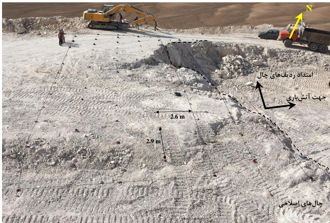
شکل (۴ - ۳۶): آرایش چال‌ها و راستای آتش‌باری آزمایشی شماره دو در پله شرقی معدن سنگ آهک جاجرم
