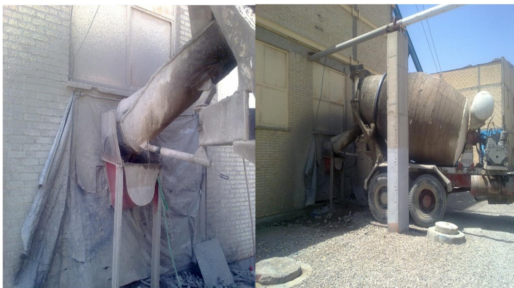
شکل ۴-۴۳- تخلیه بتن به داخل فیدر توسط تراک میکسر
