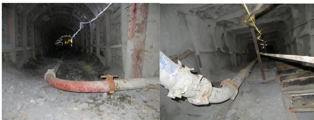
شکل ۴-۴۵ - خط لوله منشعب شده از پمپ بتن و نصب شده در تونل‌ها
