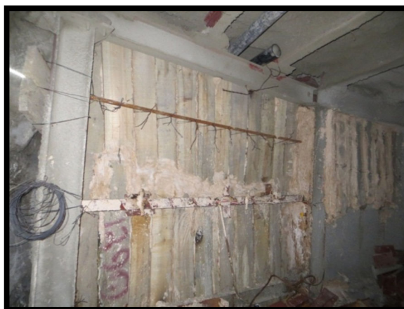
شکل ۴-۴۶ - آماده‌سازی انجام شده در کارگاه استخراج جهت پرکردن کارگاه (لارده چینی)
