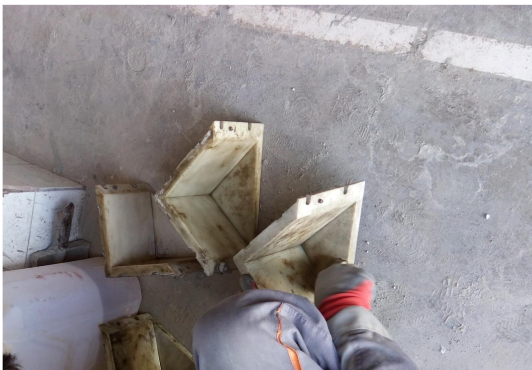
شکل ۴-۲- آماده سازی قالب‌های مکعبی برای تهیه نمونه‌های بتن
