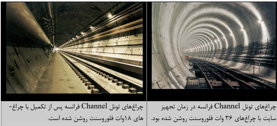
شکل ۲-۶- مقایسه نور در تونل شنل فرانسه [۴]
