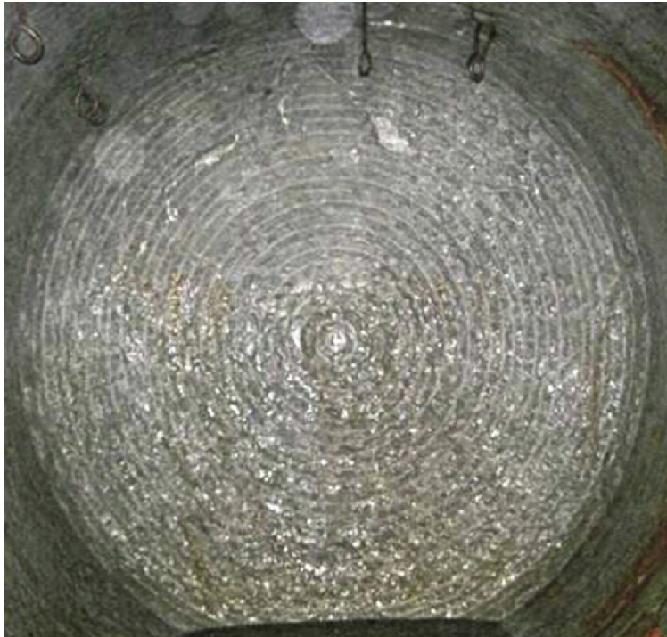
شکل ۲-۵: اثر برش‌دهنده‌های دیسکی روی جبهه کار تونل (Jain et al., 2014)
