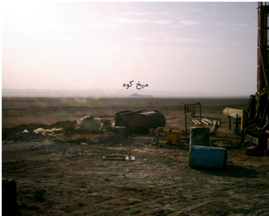
شکل (۴-۴): تصویری از حفر گمانه پنجم و کوه میخ کوه. دید دوربین به سمت جنوب است.
