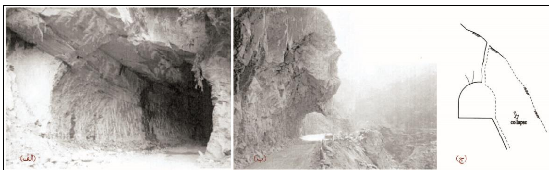
شکل ۳-۲- تخریب یکی از تونل‌های سنگی تایوان در زلزله Chi Chi (Wang et al., 2001)
