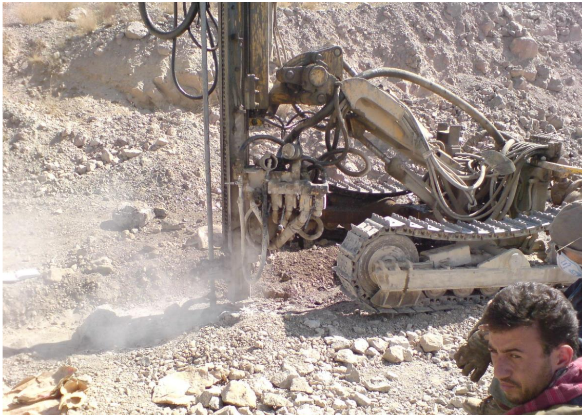
شکل ۵-۲- دستگاه حفاری در حال حفاری های آزمایشی
