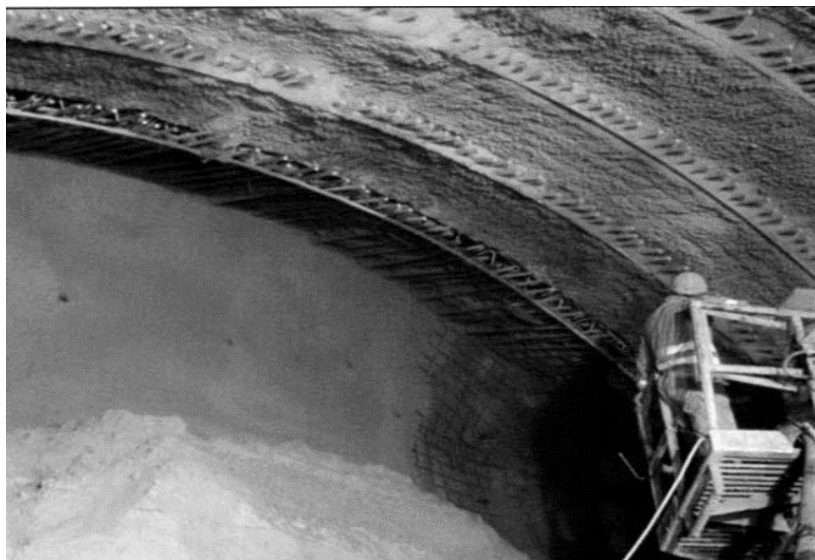
شکل ۱-۲ میله‌های نصب شده درون لتیس گیردها در هر گام، بر روی جبهه کار (Volkman et al., 2006)
