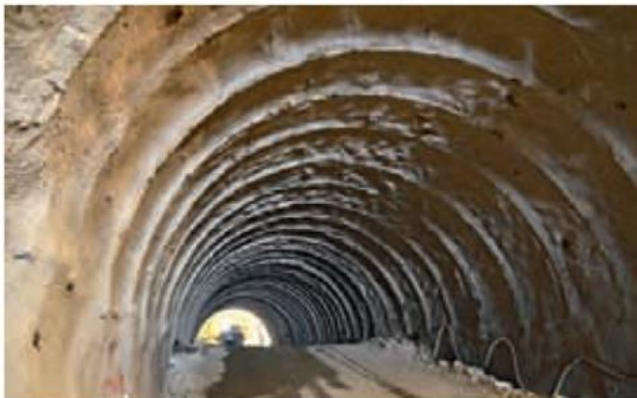
شکل ۲-۲: نمایی از مقطع تونل‌سازی با استفاده از روش پیش تحکیم سامانه‌ی چتری. افزایش سطح مقطع در هر گام قابل مشاهده است (Dywidage international catalogue, 2013).
