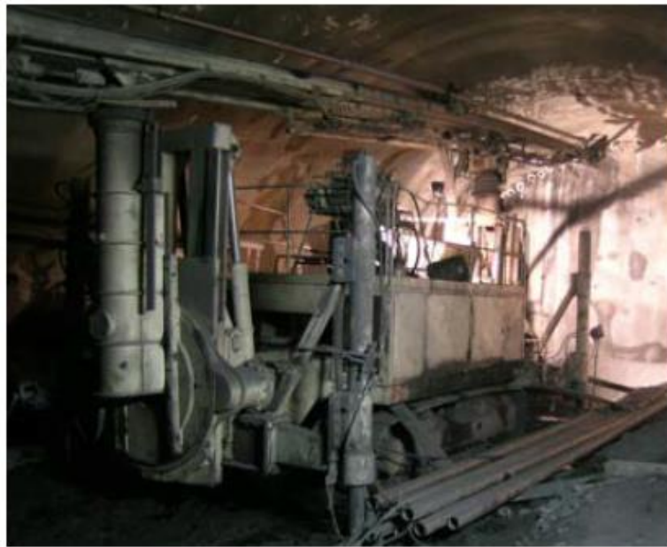
شکل ۲-۶: نمایی از دستگاه حفر و سامانه نصب لوله‌های مربوط به سامانه پیش‌تحکیم چتری به روش پیش‌حفری (Volkman & Schubert, 2007).
