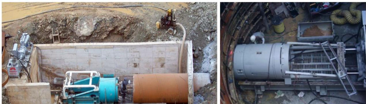
شکل ۲-۴: روش لوله‌رانی در حفر فضاهای زیرزمینی به عنوان پیش‌تحکیم (www.ekyountunnel.com).
