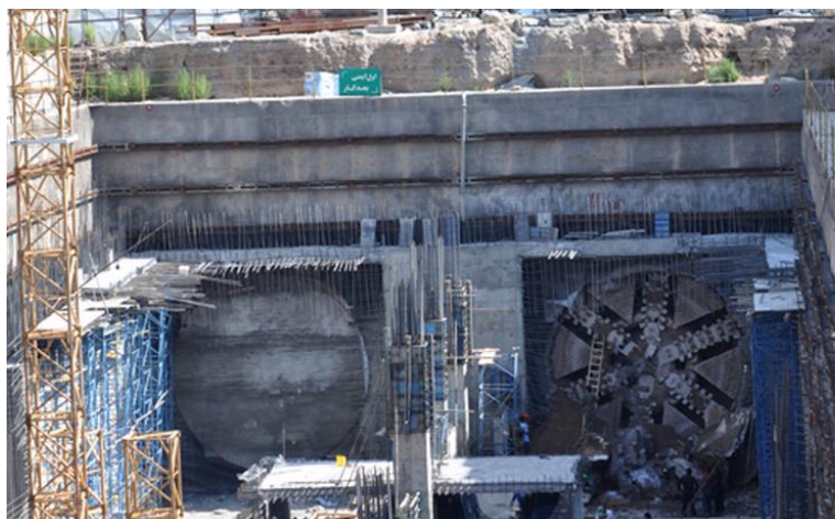
شکل ۱-۲- خروج ماشین حفار از تونل سبلان خط یک متر تبریز
