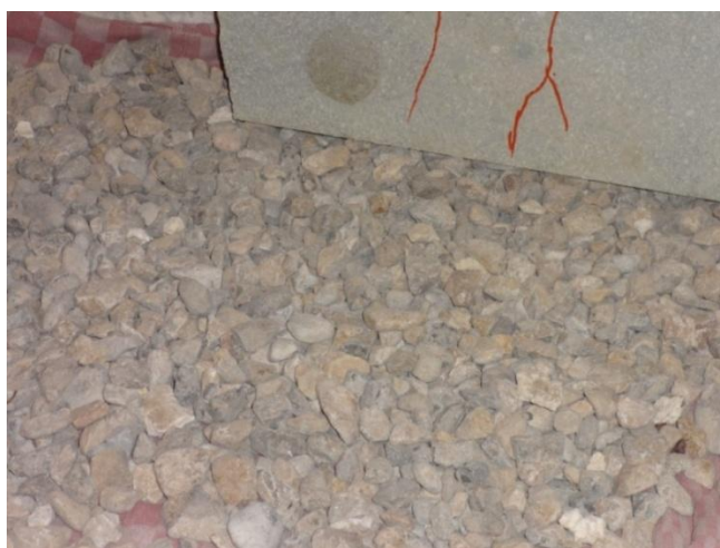
شکل ۴-۲۲: سطح ماسه بادامی تسطیح شده به ضخامت ۱۰ سانتیمتر
