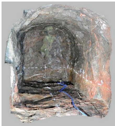
شکل (۲-۳) - سطح سه‌بعدی رنگی اسکن شده یک تونل با استفاده از اسکنر لیزری [۳۲]
