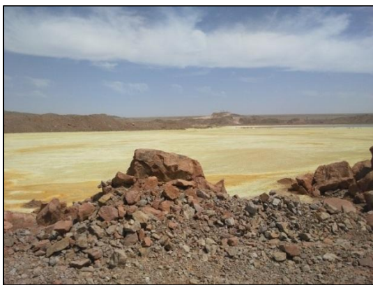
شکل ۲-۶ حوضچه باتلاقی در سد رسوبگیر معدن مس سرچشمه
