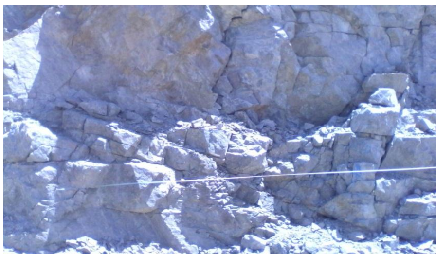
شکل ۳-۵- نمایی از متر پهن شده در یکی از بلوک‌ها
