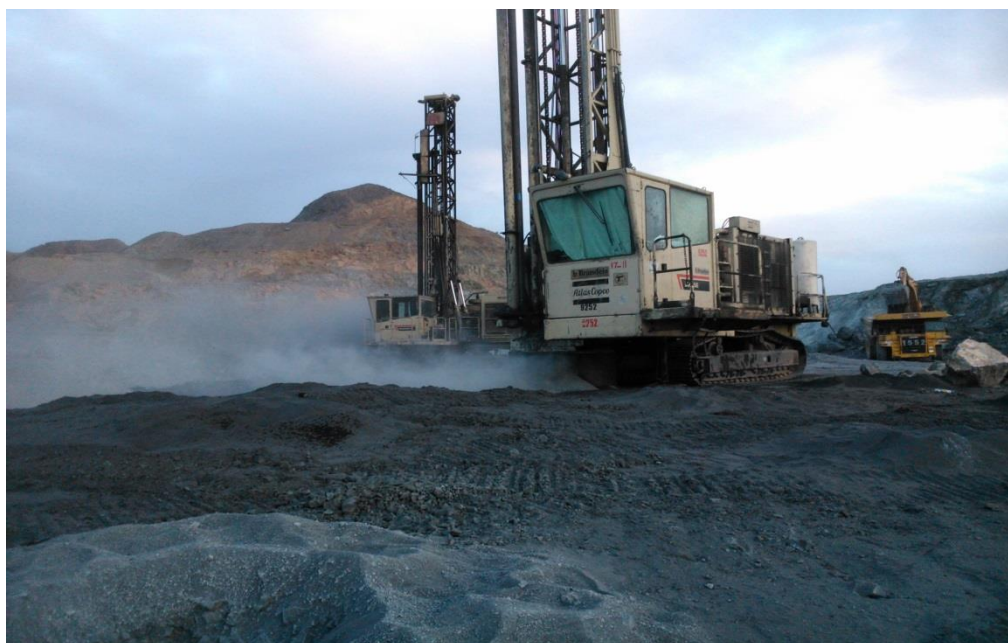
شکل ۳-۴- گرد و غبار ناشی از عملیات حفاری در معدن [۳۹]
