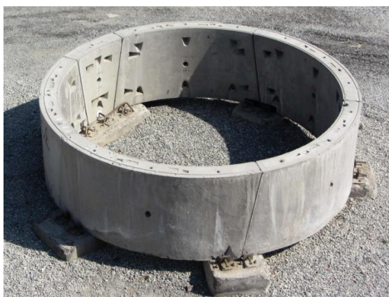
شکل (۲-۳) هندسه و چیدمان سگمنت‌ها در یک حلقه
