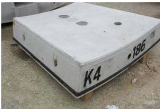
شکل (۱-۶) نوار آببند متصل شده بر روی سگمنت کلید
