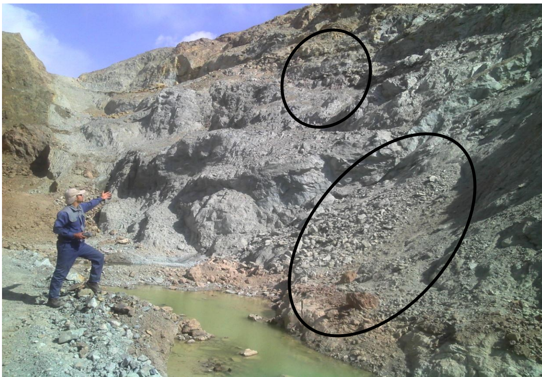
شکل ۵-۲۰: قسمت‌های ریزش کرده پله‌ها در معدن غار صالح
