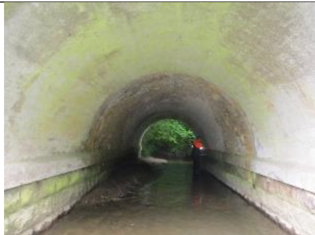
۱- بخش ابتدایی شرقی از جنس بتن
