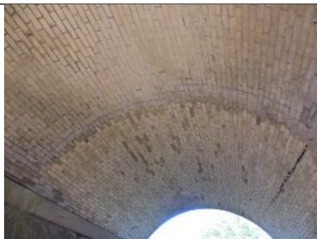
۳- حدفاصل بخش ابتدایی سازه با بدنه اصلی؛ یک ترک در طاق بدنه اصلی به فاصله‌ی حدود ۲۰ سانتی‌متر از دهانه‌ی قدیمی به چشم می‌خورد
