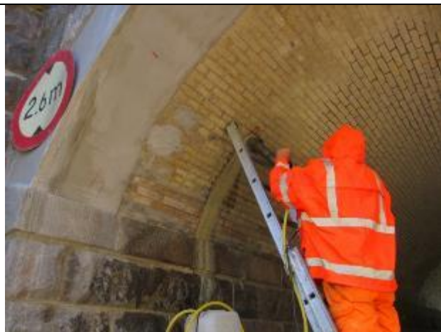
۵- گوشه‌ی جنوب شرقی سازه که نم و رطوبت در آن مشاهده شد
