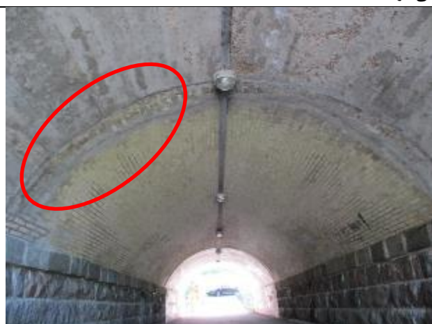
۵- انتهای غربی پل؛ لایه لایه شدگی در این بخش ایجاد شده است
