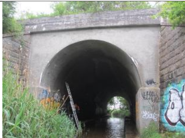
۲- نمای غربی؛ تقریباً دو متر ابتدایی از جنس بتن است
