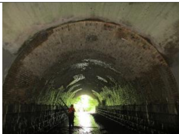
۳- انتهای شرقی سازه؛ رطوبت در دیواره‌ها و حتی تا سقف هم نفوذ کرده است
