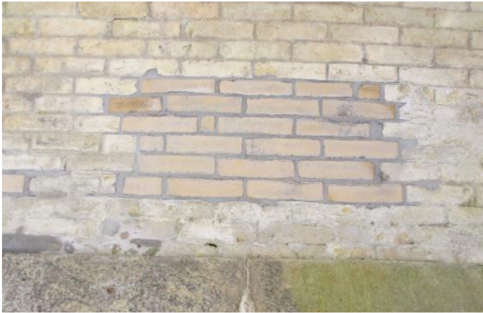
شکل ۵-۱۲: نمونه‌ای از قسمت‌های ترمیم شده که در مطالعات چسبندگی ضعیفی بین لایه آجری و لایه زیرین دارد
