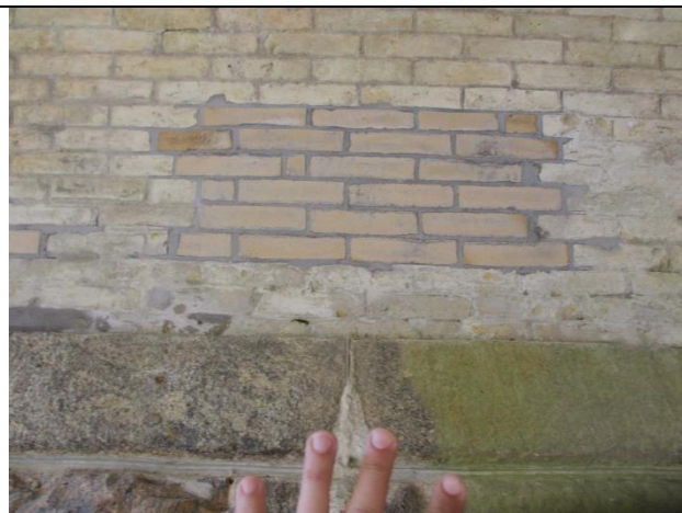
۶- نمونه‌ای از بخش‌های ترمیم شده؛ این بخش‌ها چسبندگی خوبی با لایه‌ی زیرین ندارند
