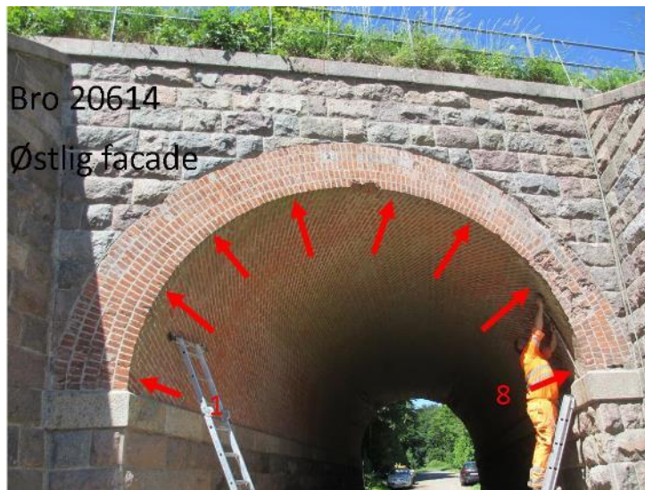
شکل ۵-۲۱: پل ۲۰۶۱۴ واقع در بردبال تیرسباکوی (Bredballe Tirsbækvej)
