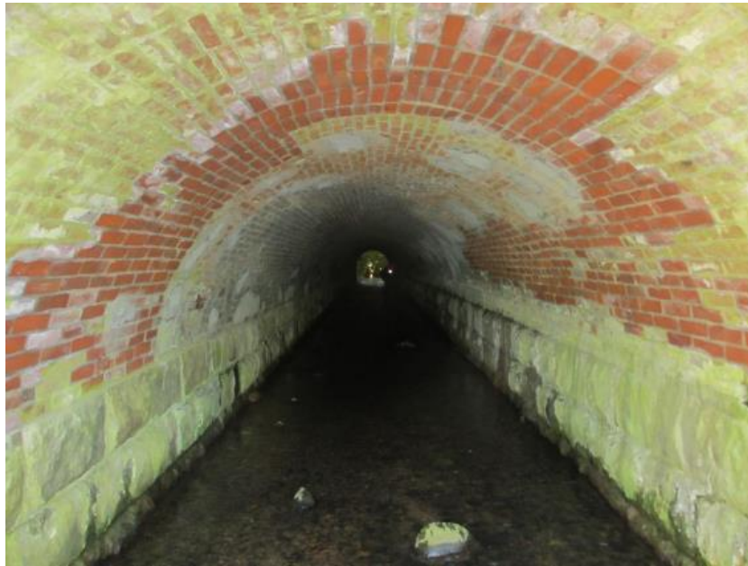
شکل ۵-۲۹: تصویری از قسمت غربی پل؛ تعداد محل‌های ترمیم شده قابل توجه است
