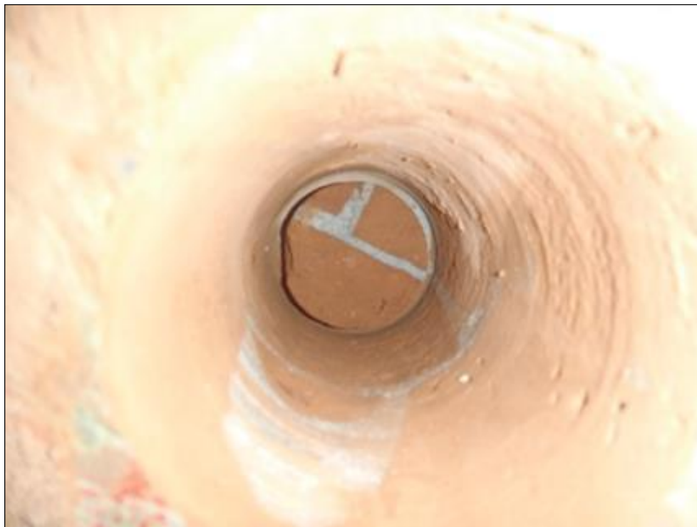
شکل ۵-۲۵: محل مغزه برداشت شده از قوس زیرین پل ۲۰۶۱۴
