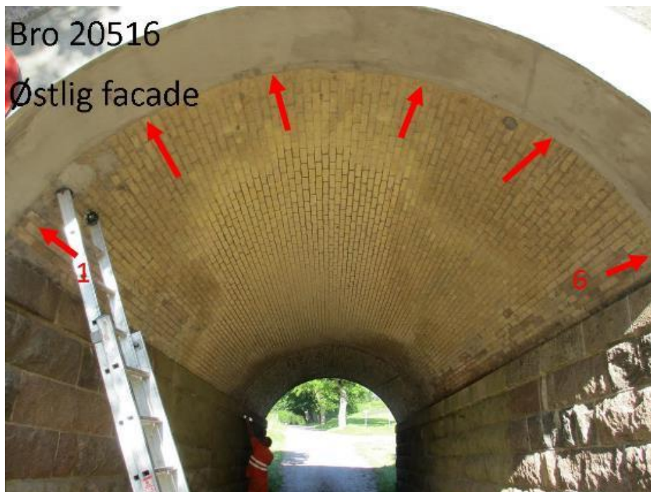
شکل ۵-۱۰: پل ۲۰۵۱۶ واقع در برونستد مولیوای (Brøndsted Møllevej)
