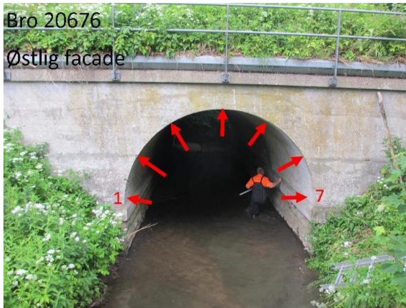
شکل ۵-۳۵: پل ۲۰۶۷۶ واقع در وندلوب (vandløb)
