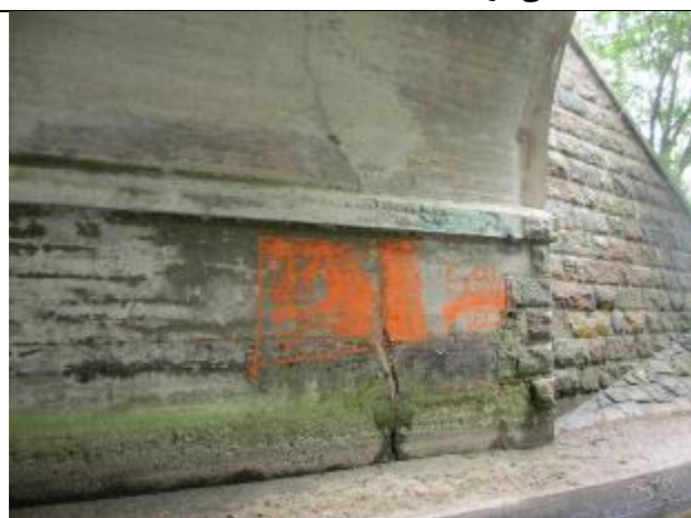
۵- انتهای شرقی پل؛ ترک نسبتاً بزرگی در فاصله‌ی حدود ۲ متری از انتها مشاهده می‌شود
