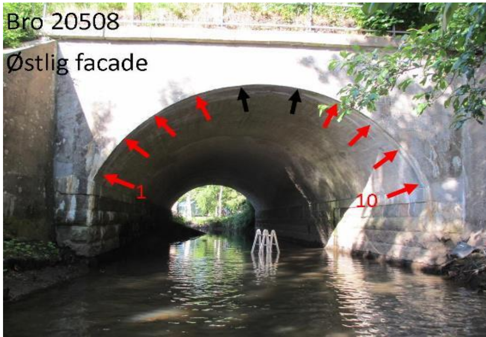
شکل ۵-۶: پل ۲۰۵۰۸ واقع در اسپانگو (Spang Å)
