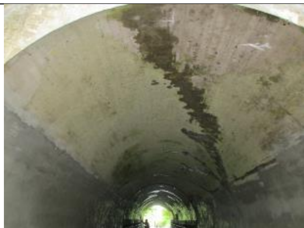
۴- طاق بخش ابتدایی غربی که از جنس بتن است؛ ترک و رطوبت به وجود آمده در آن در تصویر دیده می‌شود
