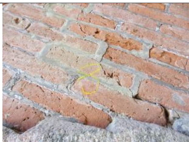
۵- ترک نسبتاً بزرگ که در فاصله‌ی ۸ متری دهانه‌ی شرقی ایجاد شده است
