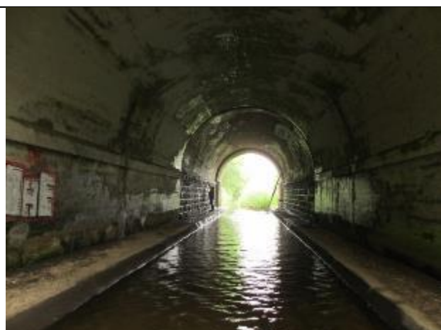
۶- نمای شرقی - غربی سازه؛ نفوذ آب در سقف و دیواره به چشم می‌خورد
