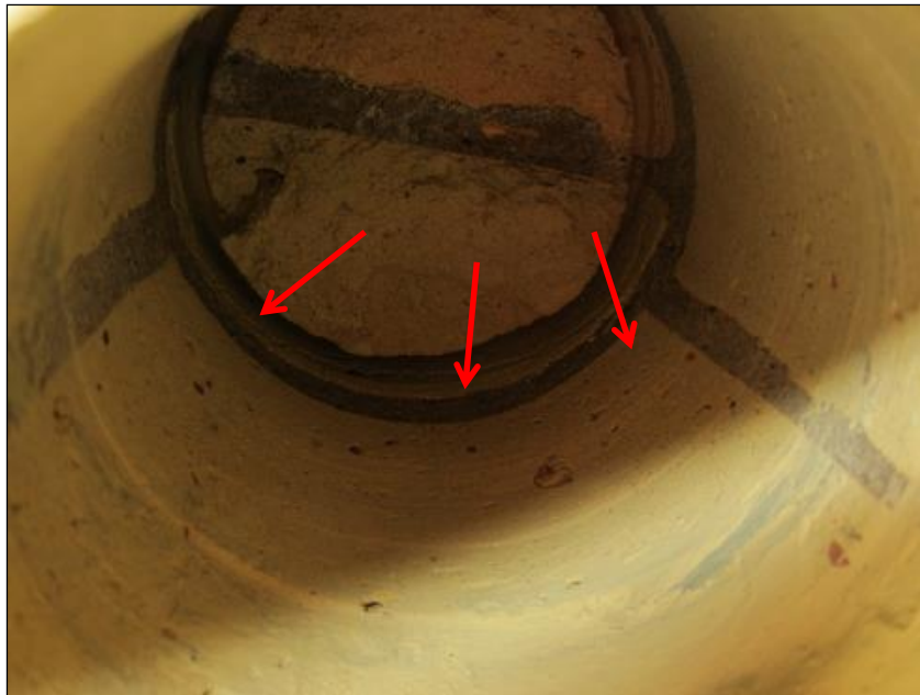
شکل ۵-۱۴: محل مغزه گرفته شده از پل ۲۰۵۱۶، ترک در لایه‌ی دوم آجری دیده می‌شود
