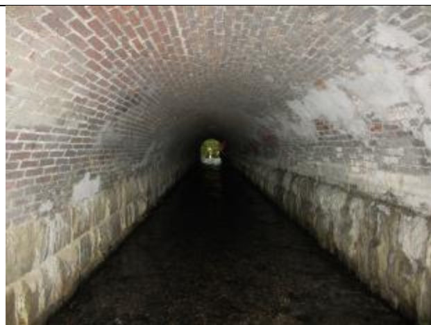
۳- بخش میانی؛ ترمیم‌های قدیمی تر و لکه گیری با بتن در این بخش مشاهده می‌شود
