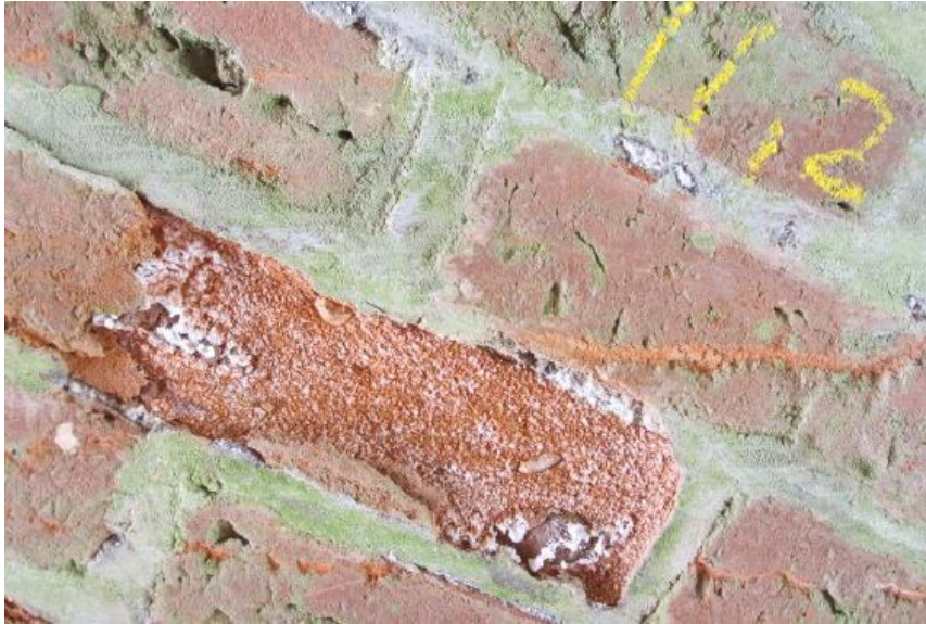
شکل ۵-۲۳: نمونه‌ای از یک آجر که بخش خارجی آن دچار تورم شده است. بخش‌های سفید رنگ نشانگر وجود نم و رطوبت در سازه است
