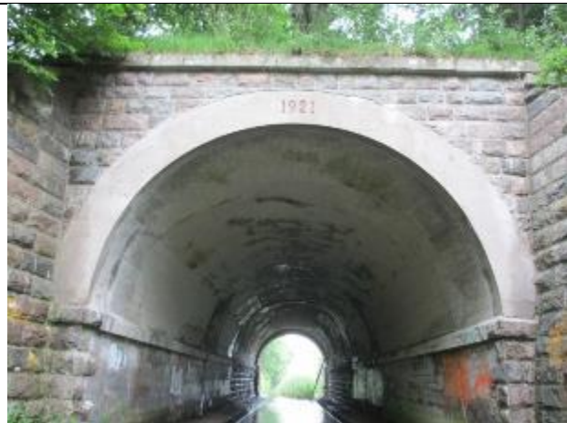
۱- نمای شرقی؛ بخش انتهایی از جنس بتن
