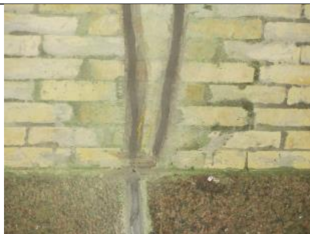
۳- ترک ترمیم شده است ولی هنوز آثاری از آسیب به چشم می‌خورد
