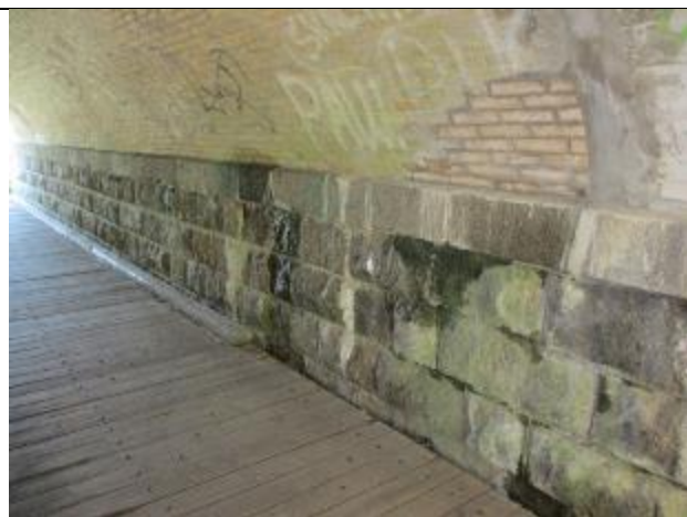
۳- دیواره‌ی شمالی سازه؛ نفوذ آب به سازه در این قسمت مشاهده می‌شود
