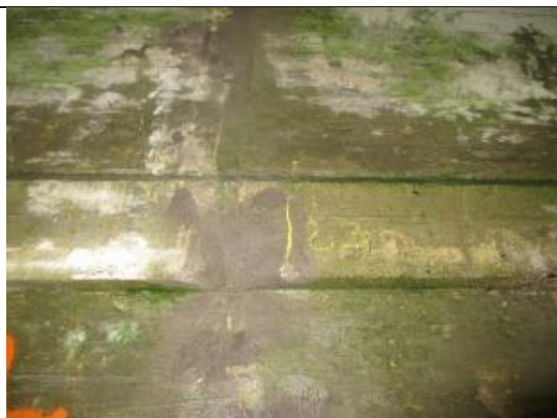
۳- تقریباً در فاصله ۲۳ متری از دهانه‌ی غربی ترک ترمیم شده‌ای دیده می‌شود
