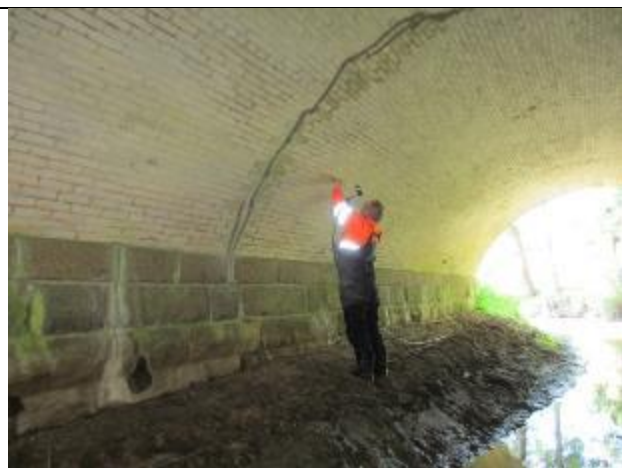
۴- در میانه‌ی سازه یک ترک بزرگ مشهود است که تا وسط طاق پیش‌روی کرده است
