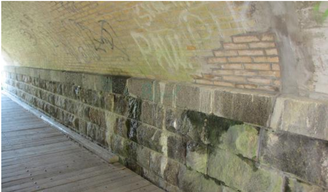
شکل ۵-۱۸: نمونه‌ای از محلی تعمیر شده از سازه؛ مطالعات نشان می‌دهد که چسبندگی ضعیفی بین لایه آجری با لایه‌ی زیرین آن وجود دارد. این بخش در نمودار شکل ۵-۱۵ به رنگ زرد نشان داده شده است.
