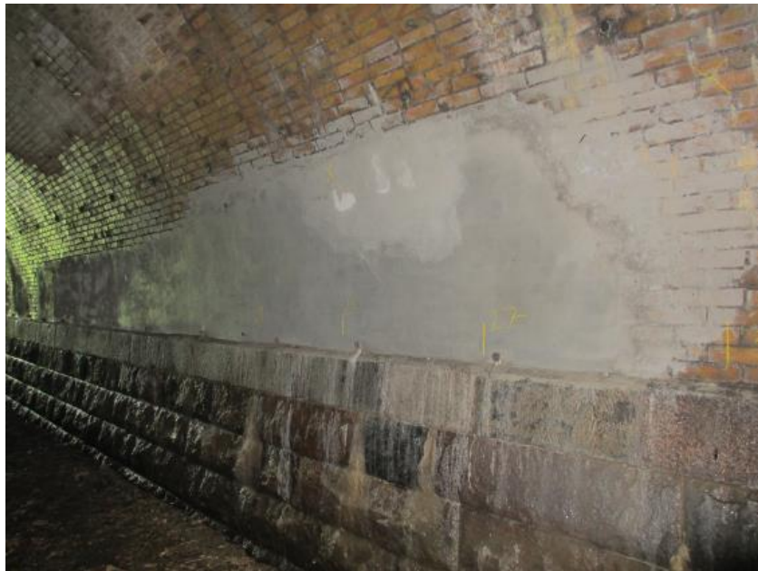
شکل ۵-۳۳: تصویری از قسمت جنوبی سازه که ترمیم شده است
