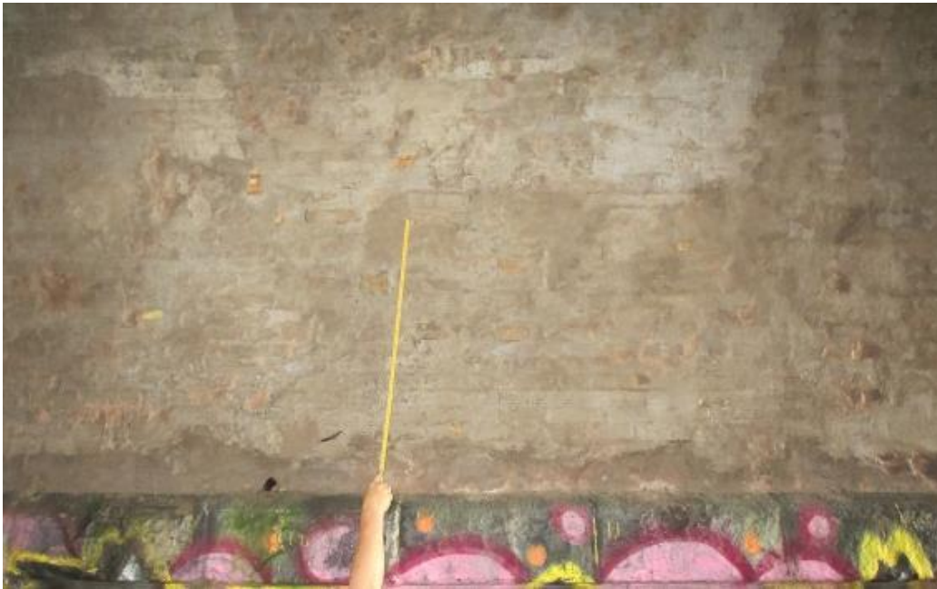
شکل ۵-۴۲: محل برداشت مغزه در دیواره‌ی سازه؛ سطح خارجی دیواره پولیش داده شده است
