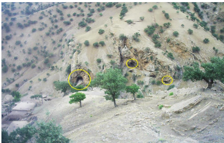
شکل (۵-۶) غارچه‌های انحلالی در مسیر تونل نوسود [۲۲۲]
