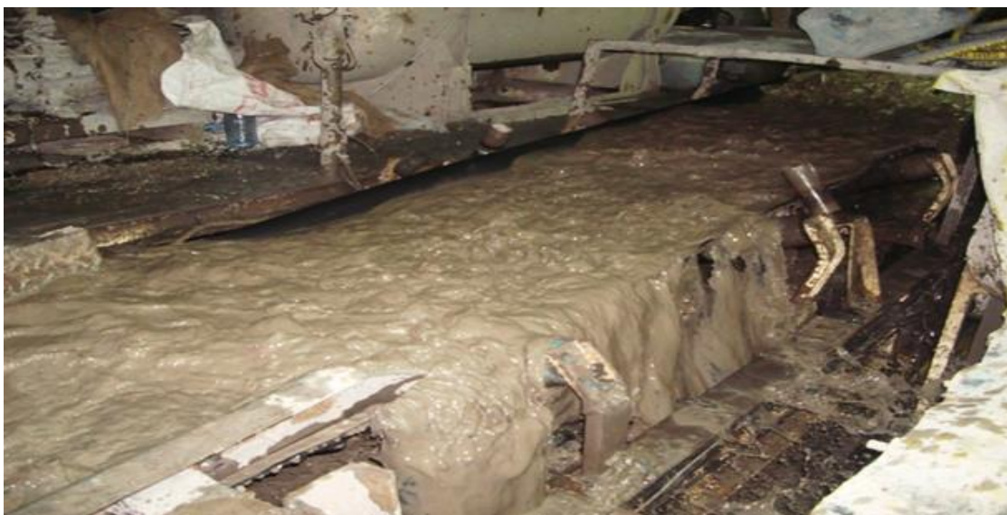
شکل (۶-۱۰) نمایی از هجوم آب در هنگام تخلیه‌ی نخاله‌ی حاصل از حفاری بر روی نوار نقاله
