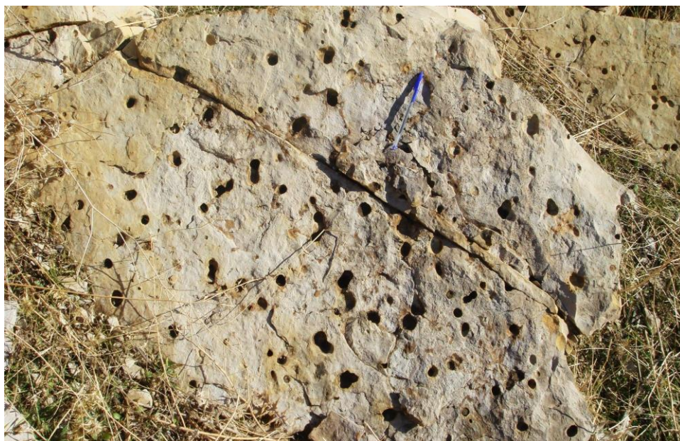
شکل (۶-۶) وجود حفره‌های اکسید آهن در سطح آهک‌های تاقدیس اسپر [۲۲۳]
