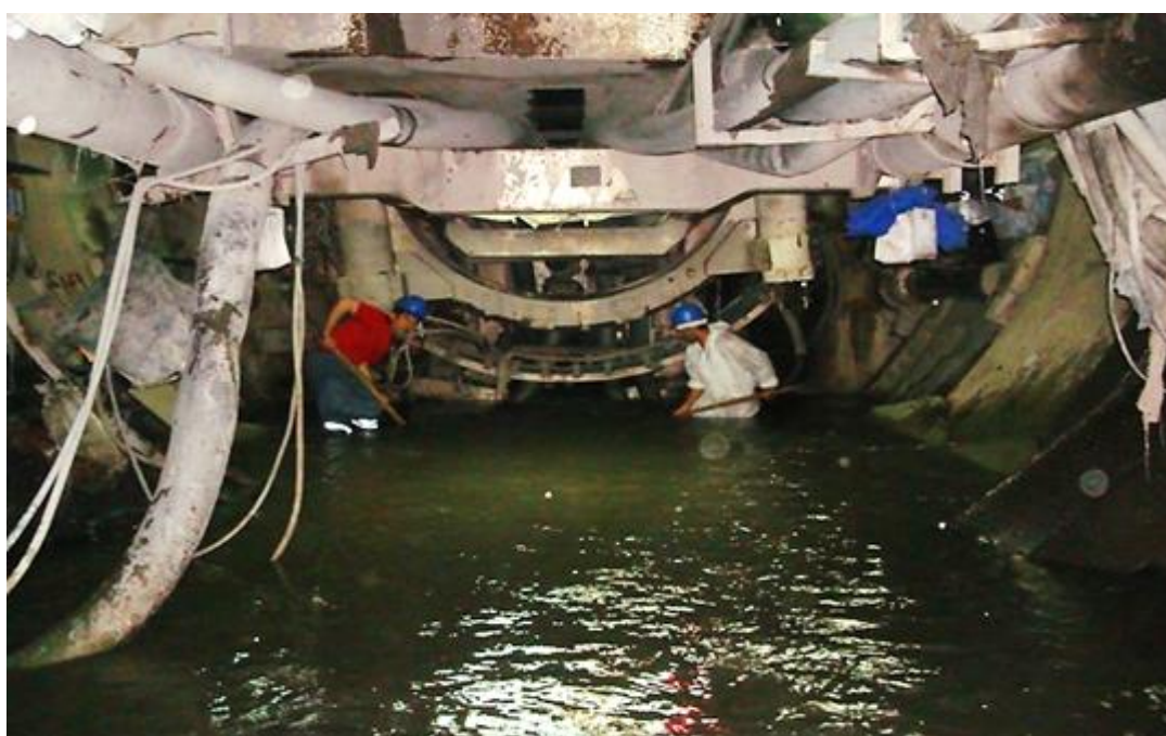
شکل (۶-۱۱) هجوم آب به داخل تونل و بالا آمدن سطح آب در محدوده‌ی ریل‌گذاری
