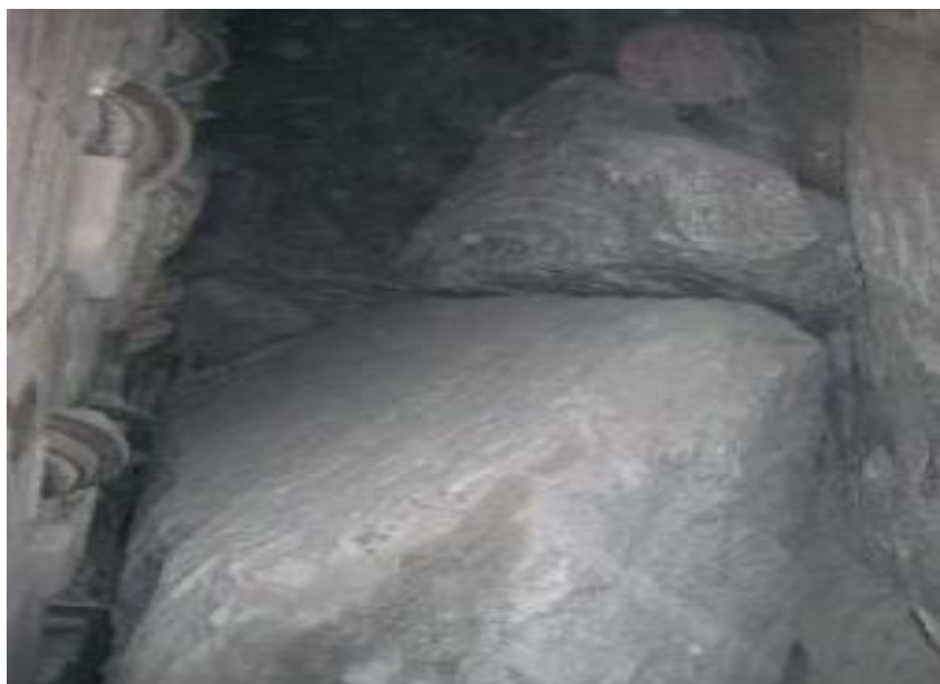
شکل (۲-۵) بلوک‌های بزرگ جدا شده از سینه‌کار تونل [۱۷۳]
