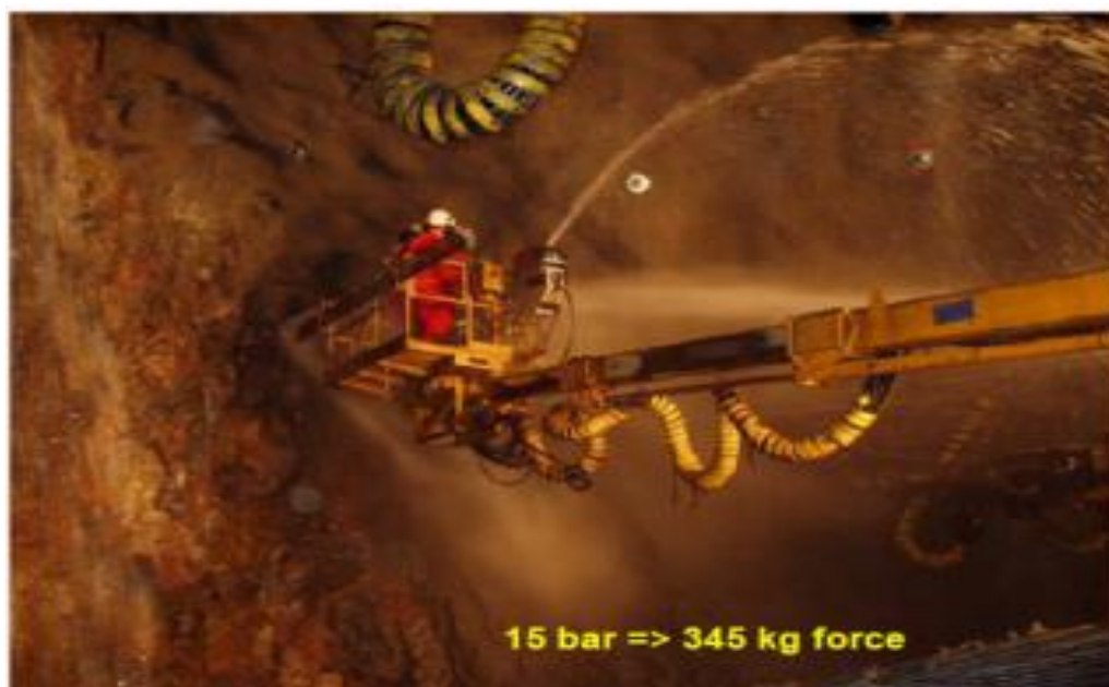
شکل (۴-۵) نمونه‌ای از هجوم آب به داخل تونل [۱۷۹]
