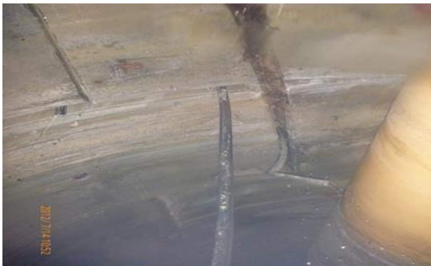
شکل ۳-۲۳- رهاشدگی نوار آببند از محل اتصالات (پروژه قمرو، ایران)
