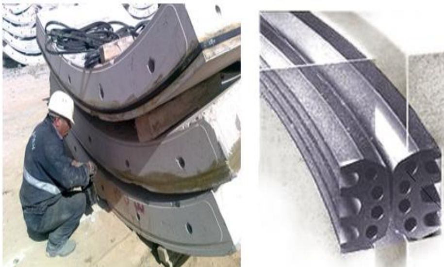
شکل ۲-۱۲- استفاده از نوارهای آب‌بند و چگونگی نصب آن‌ها (پروژه قمرود، ایران)
