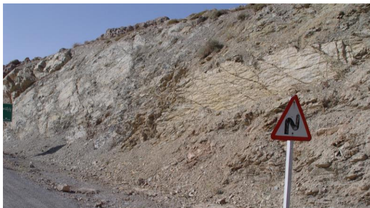
شکل ۲-۷- رخنمون مارن‌های سبز در محل گردنه و درجه هوازدگی آنها، سمت شیب لایه‌ها [۳۰]
