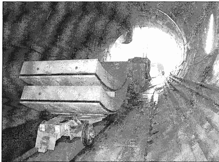
شکل ۲-۳۰ انتقال سگمنت به داخل تونل
