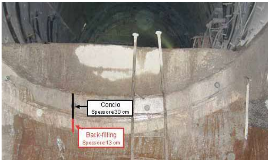
شکل ۲-۵: نمونه‌ای از پرکردن فضای خالی بین پوشش بتنی و مقطع حفاری [۴]
