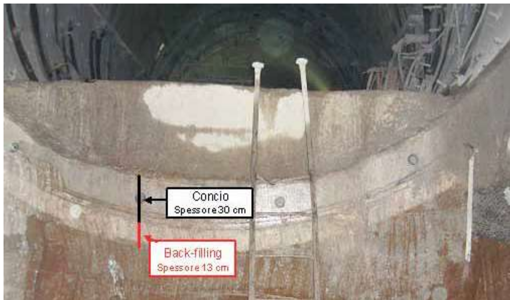
شکل ۱-۴ : نمونه ای از پرکننده فضای بین پوشش سگمنتی و مقطع حفاری در تونل مترو رم ایتالیا [۱۵]
