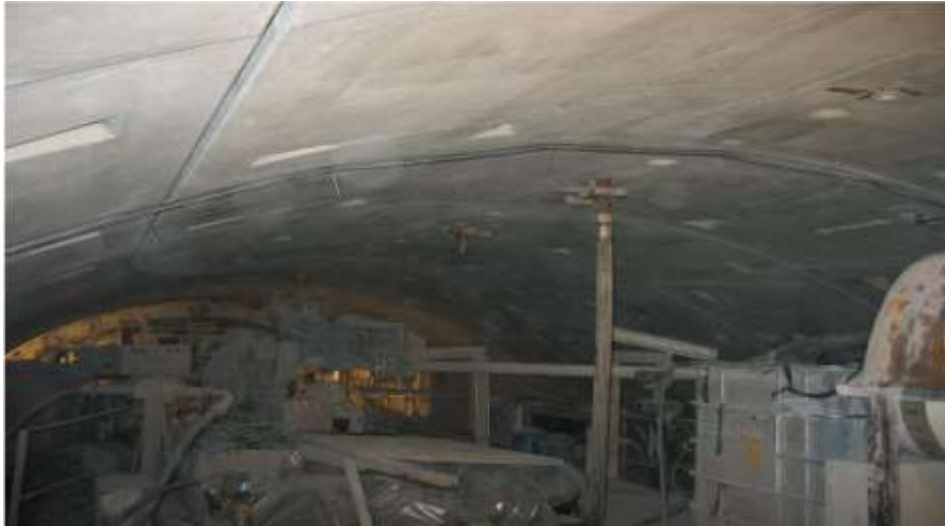
شکل ۲-۲ : نمونه‌ای از تزریق از چال‌های روی سگمنت‌ها (تزریق شعاعی) [۳]
