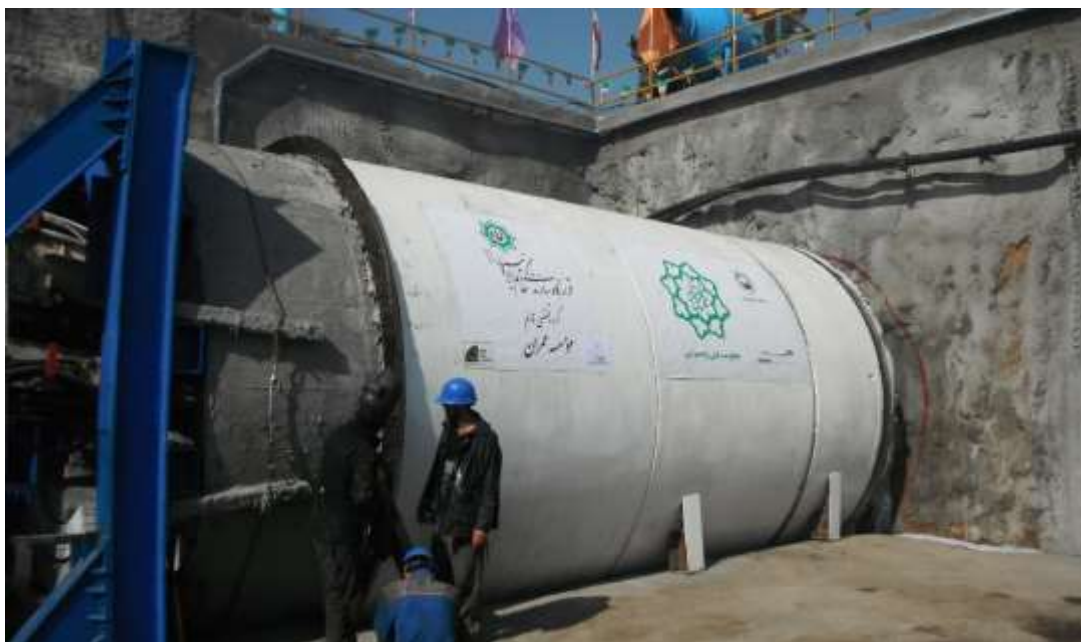
شکل ۳-۴ : ماشین حفاری مورد استفاده در حفاری تونل کمکی کانال ابوذر [۲۰]
