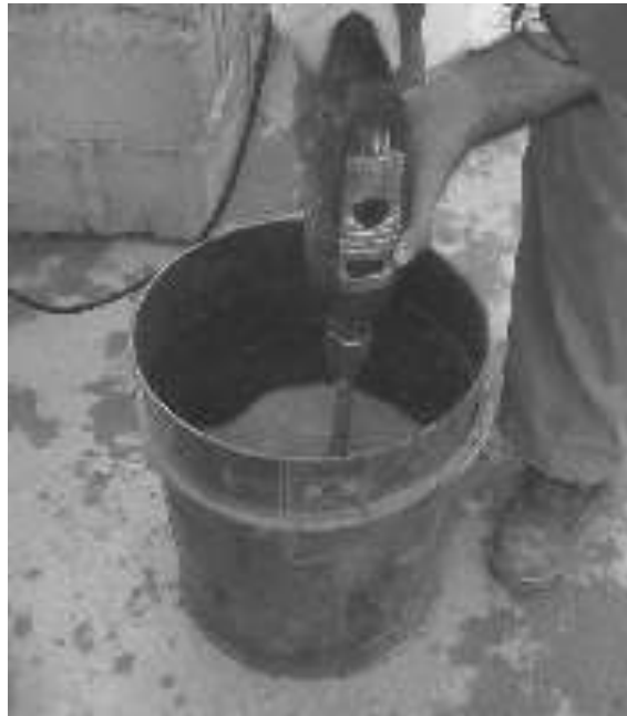
شکل ۳-۵ : عمل آوری بنتونیت با همزن دور بالا
