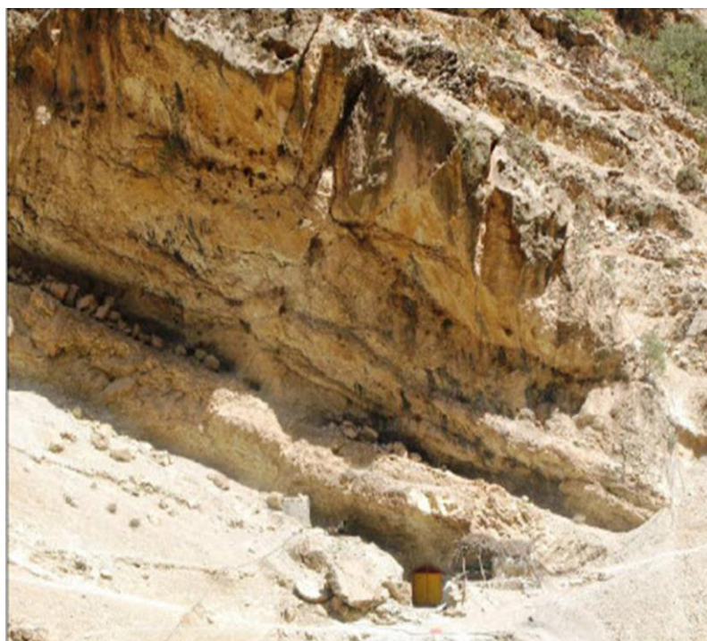
شکل (۶-۲): نمایی از گالری GR2 حفاری شده در واحد UAS2 (گلشن و همکاران، ۱۳۸۹).
