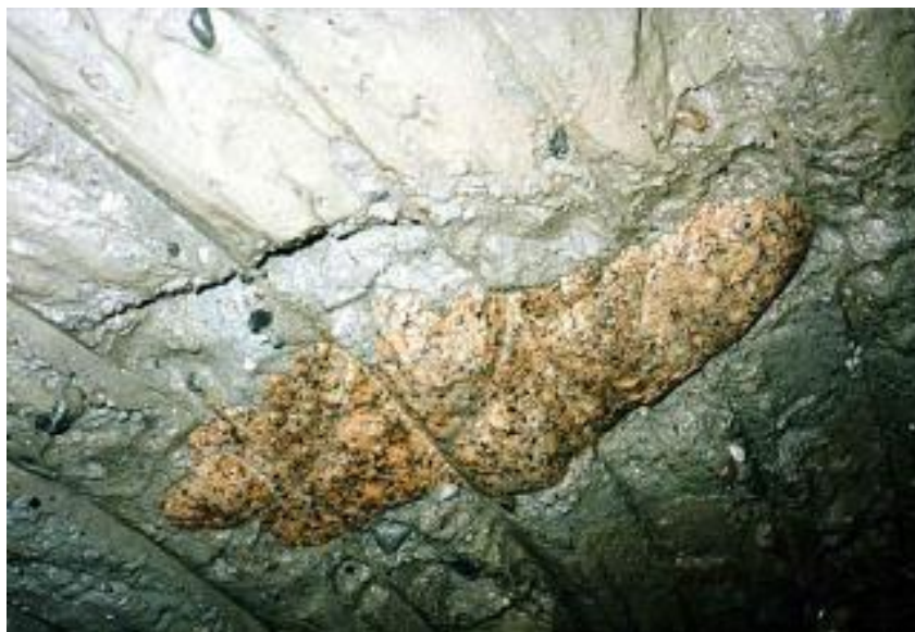
شکل (۳-۳) وجود بولدر در مسیر حفاری تونل [۵۰]
