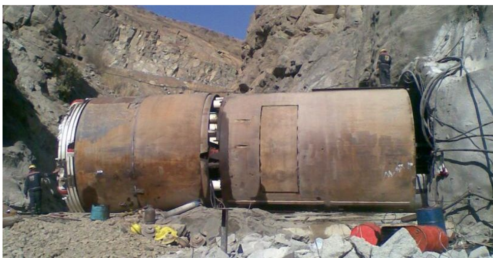
شکل ۵-۱۱- انتقال TBM از قطعه ۱ به قطعه ۲ پس از اورهال (کرج ۲)
