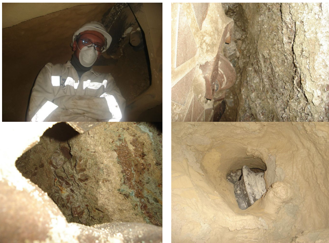
شکل ۴-۵- بازدید از سینه کار، تونل کرج ۱ (زون‌های ناپایدار، سینه کار مختلط و کلاگینگ)
