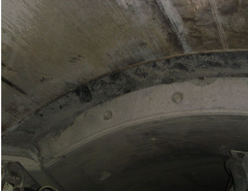
شکل ۴-۹- چسبیدن زمین به شیلد و سگمنت در اثر پدیده لهیدگی (تونل قمرود ۳ و ۴)
