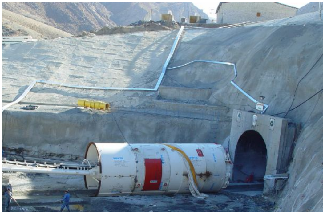
شکل ۵-۱۹- TBM مورد استفاده در تونل قمرود (قطعات ۳ و ۴)
