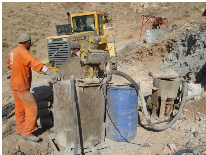
شکل ۴-۲- تزریق دوغاب از سطح زمین به منظور بهسازی زمین (تونل کرج ۱)
