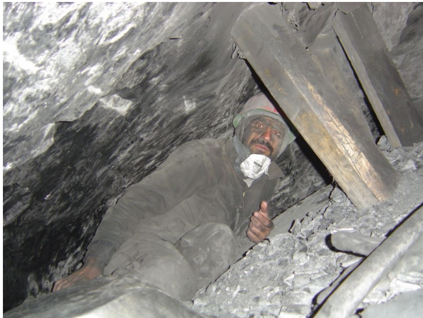
شکل ۴-۱۰- حفاری دور سپر به منظور آزادسازی آن (تونل قمرود ۳ و ۴)
