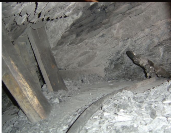
شکل ۵-۲۱- بازدید از عملیات اجرایی و سینه کار (تونل قمرود) (پایین سمت چپ: واحد شیلی، آزادسازی شیلد. راست: سینه کار واحد آهکی)
