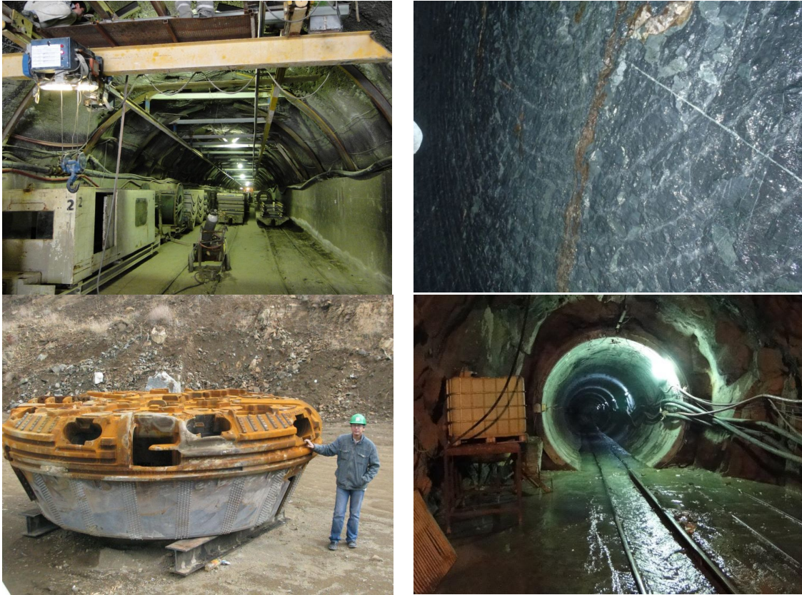
شکل ۵-۱۳- سایت کرج ۲، تعویض کاترهد TBM بازدید سینه کار و جریان آب زیرزمینی (کرج ۲)
