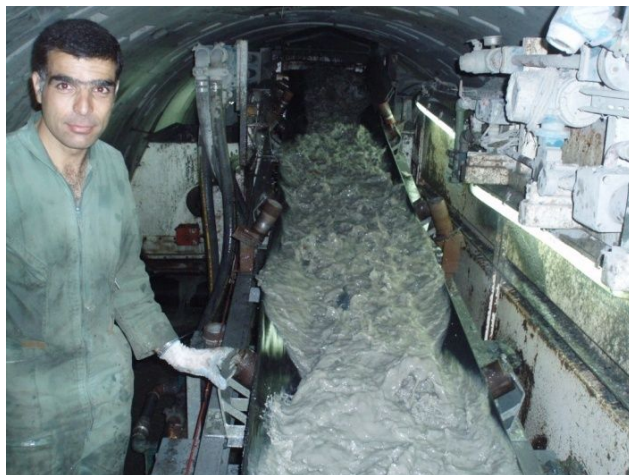
شکل ۴-۶- جریان آب بر روی نوار نقاله (تونل کرج ۲)
