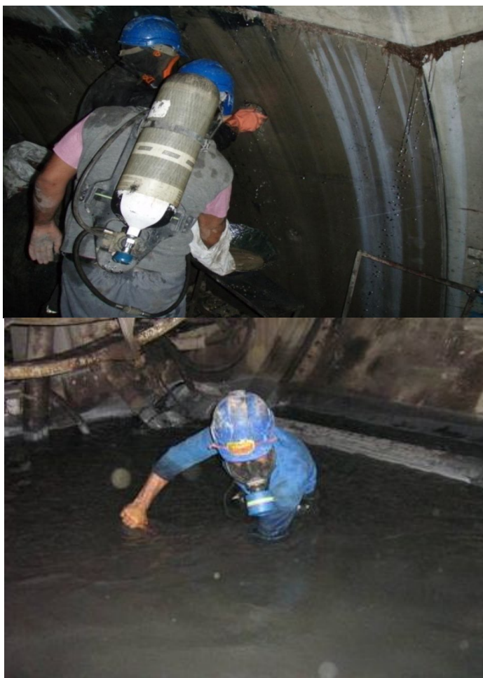
شکل ۴-۱۱- شرایط آب زیرزمینی و گاز - کار با استفاده از کپسول هوا و ماسک (تونل نوسود ۲)
