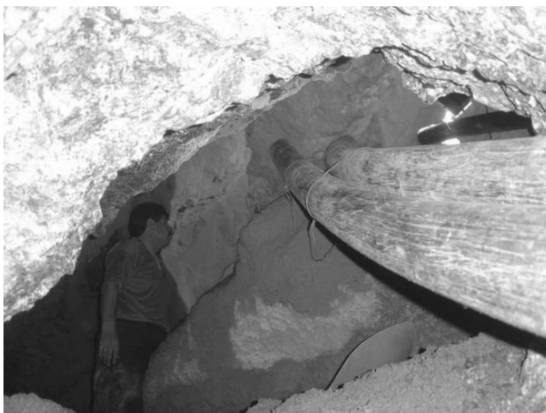
شکل (۵ ۶) عمق ریزش سقف در بالای کاترهد در اثر ناپایداری سقف تونل گاوشان
