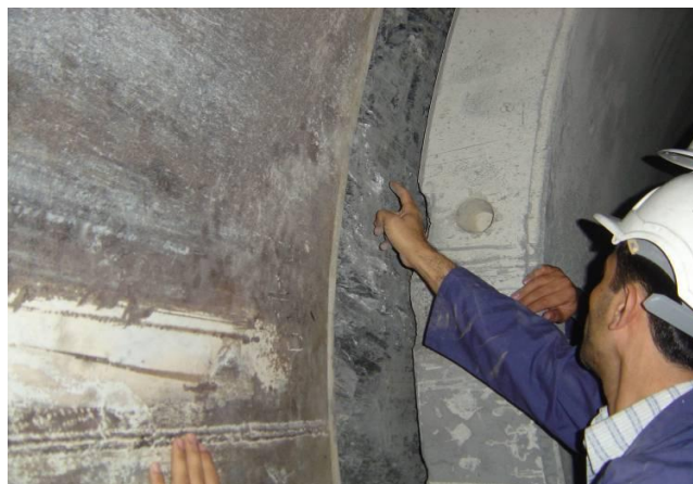
شکل (۴ ۵) پدیده مچاله شوندگی و چسبیدن سنگ اطراف تونل به سگمنت و شیلد (قطعات ۳ و ۴ تونل قمرود) [۱۰۳]
