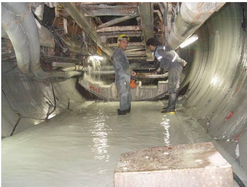
شکل (۵ ۴) جریان آب زیاد در کف تونل و صعوبت کار برای پرسنل در قطعه دوم تونل انتقال آب قمرود [۱۰۳]
