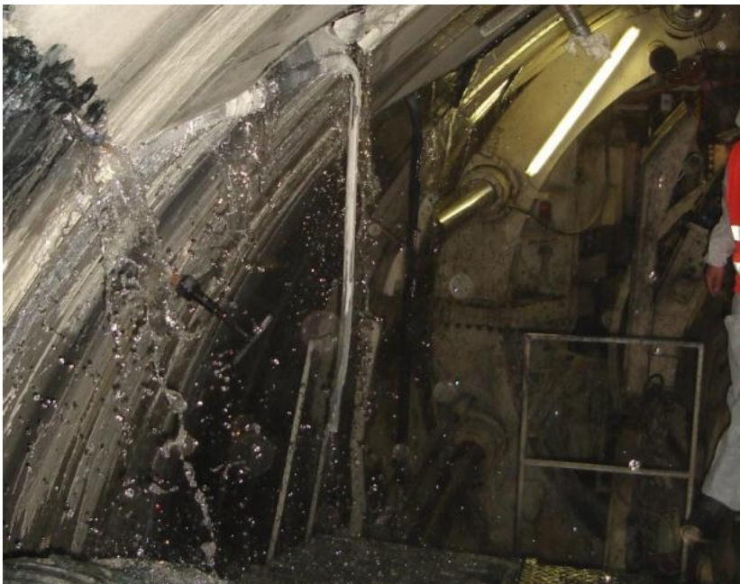
شکل (۵ +) ریزش آب از دیواره‌های تونل و صعوبت کار برای پرسنل در تونل انتقال آب زاگرس (قطعه دوم) [۱۰۳]
