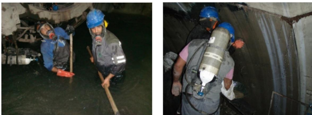
شکل (۵ ۴) پرسنل در حال کار در شرایط وجود حجم زیاد آب و گاز در تونل زاگرس [۱۱۳]
