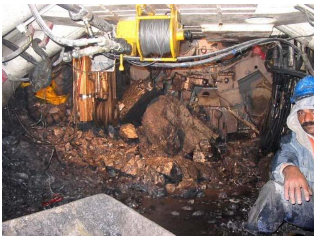
شکل (۵ ۵) ریزش و ناپایداری سینه کار تونل در پروژه البرز [۱۰۳]
