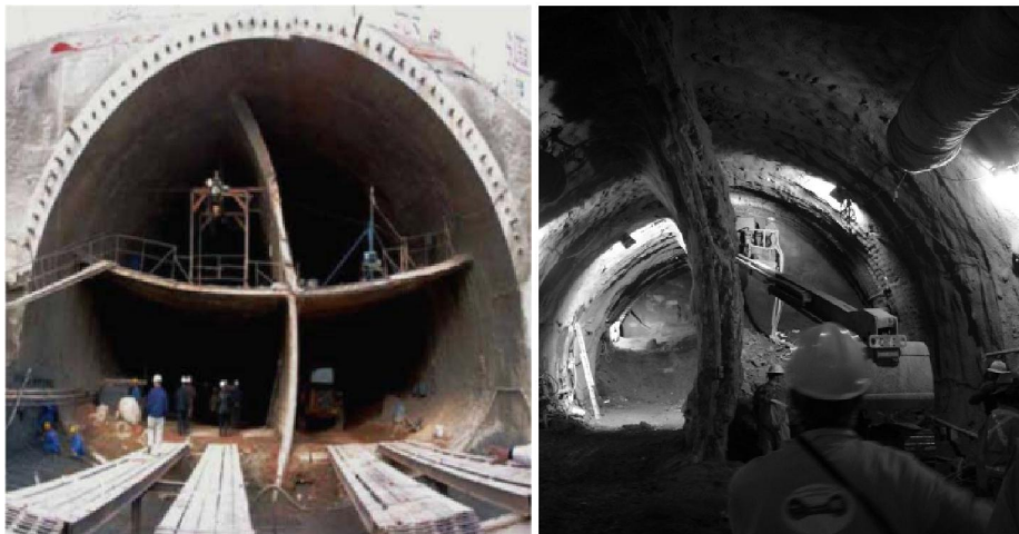
شکل ۲-۴- حفاری تونل با دیواره موقت میانی (سمت راست: تونل Beacon hill، واشنگتن) (Hung C.J. et al, ۲۰۰۹)
