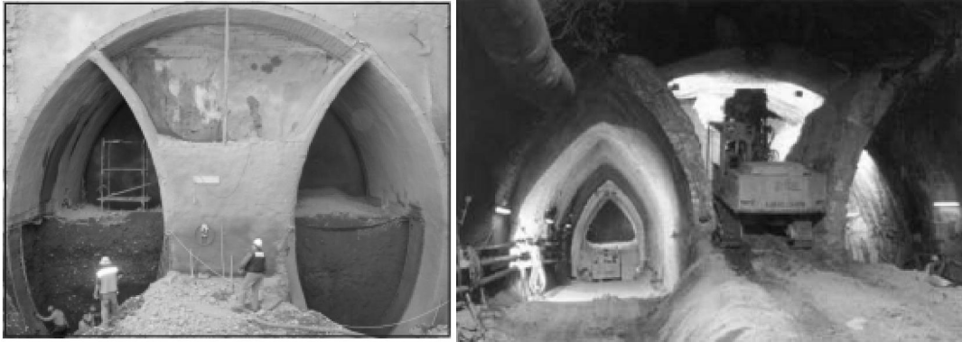
شکل ۲-۵- حفاری تونل به روش گالری‌های کناری (Sauer, G. et al, ۲۰۱۰)
