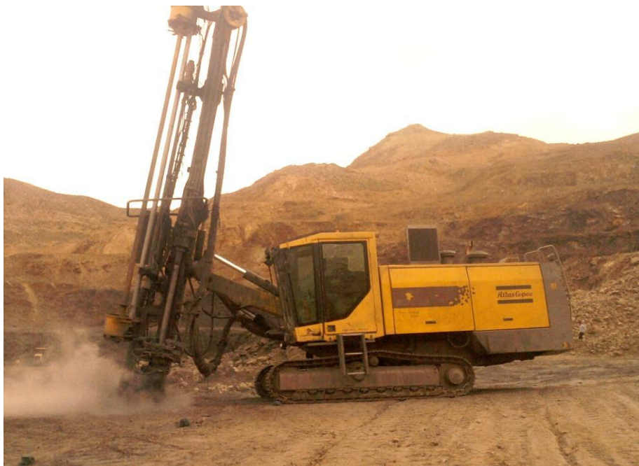
شکل ۵-۴- دستگاه حفاری Roc L8 در حال حفاری در معدن دردوی
