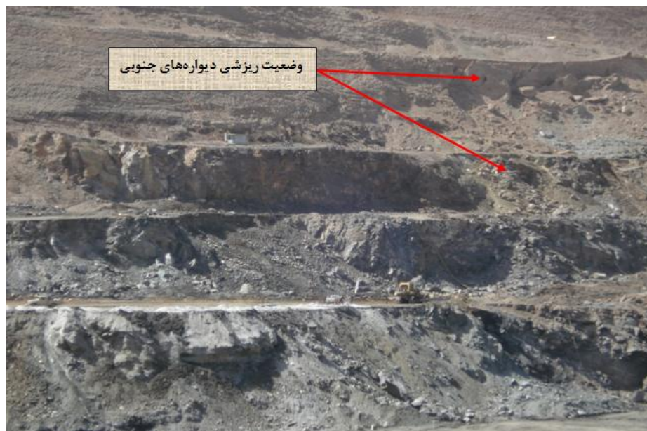
شکل (۳-۴): نمایی از دیواره‌های جنوبی معدن شماره ۱ گل گهر و مشاهده وضعیت ریزشی دیواره‌ها
