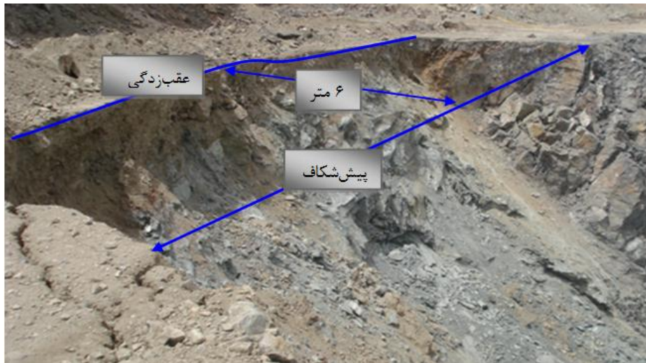
شکل (۴-۱۰): عقب زدگی و ریزش دیواره در اثر آتشکاری چال های تولیدی آزمایش اول
