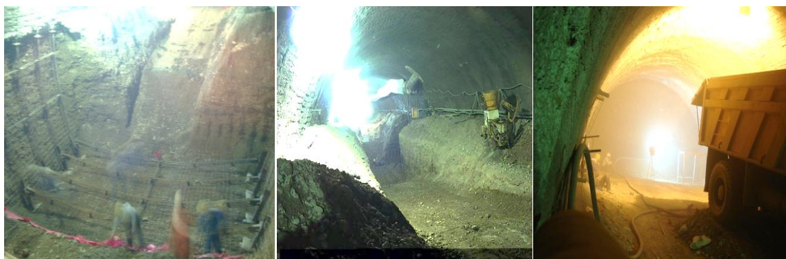
شکل ۴-۷- مراحل حفاری تونل، Heading و Benching (شرکت مهندسی مهتاب قدس، ۱۳۸۶)
