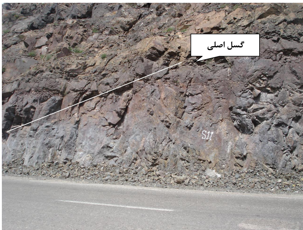
شکل ۴-۱۰- نمونه‌ای از گسل‌های اصلی بر روی شیب سنگی شماره ۱۱
