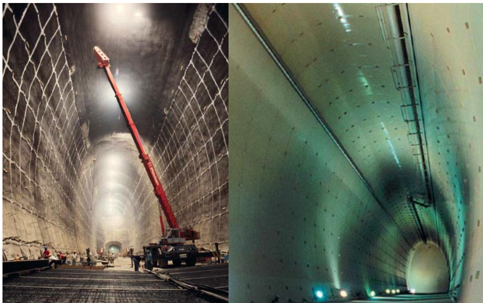
شکل (۲-۲): مغارهای دارای پوشش ذخیره سازی فرآورده های نفتی در عربستان: ابها (Aramco, 2003 & 2009)
