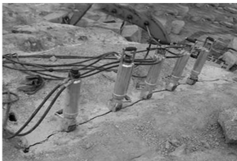
شکل ۲-۲- استفاده از جک هیدرولیک در برش سنگ (nobodybuy website)
