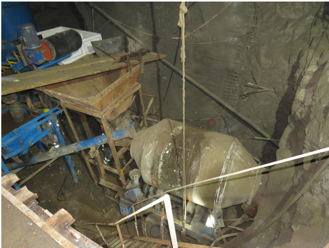
شکل ۳-۶: حفر مغار و نصب تجهیزات بچینگ در انتهای تونل ۲
