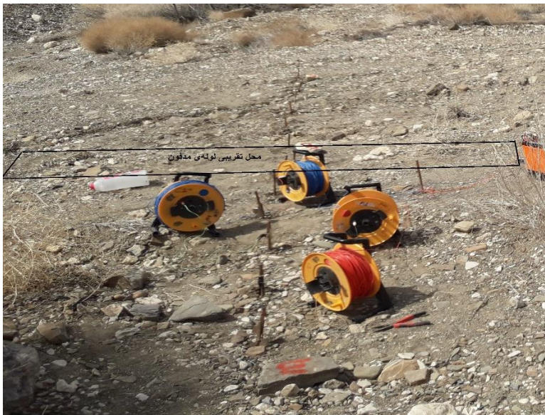
شکل ۴-۷. پروفیل A3 روی لوله‌ی مدفون (دید از شمال به جنوب).
