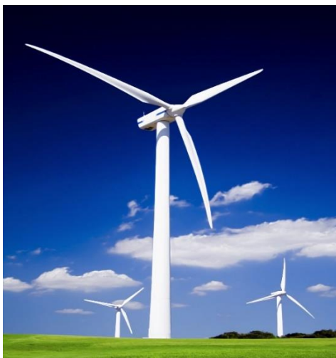
شکل ۱-۳: توربین بادی محور افقی [۱]
