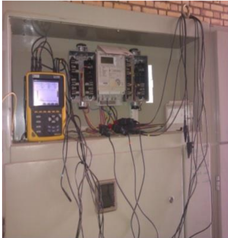
شکل ۴-۳۴ عکس از تجزیه و تحلیل PQ در پست 20 / 0.4KV کیلو ولت از شرکت مسکران سمنان.
