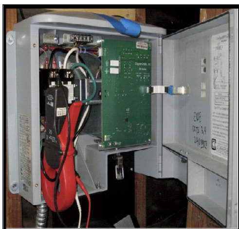
شکل (۲-۶): یک سیستم شارژ خانگی ۳.۳ کیلو وات ساعتی ساخته شرکت الپیک و یک سیستم اندازه گیری شارژر برای شارژ خانگی [۸]
