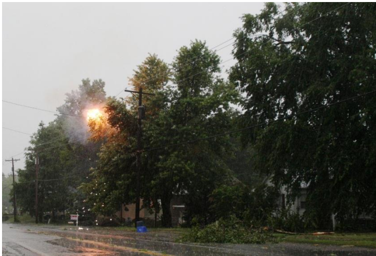
شکل (۲-۲): وقوع یک خطای اتصال کوتاه در یک سیستم توزیع به علت طوفان و بارش باران
