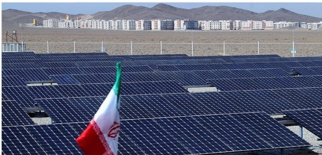
شکل ۴.۱: یک نیروگاه فتوولتائیک در ایران
