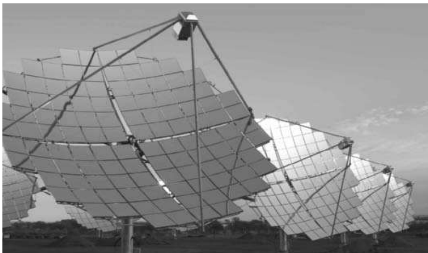
شکل ۲-۶. ایستگاه سلول‌های خورشیدی تحت تمرکز با توان ۱۹۰ kW استرالیا [۲۶].
