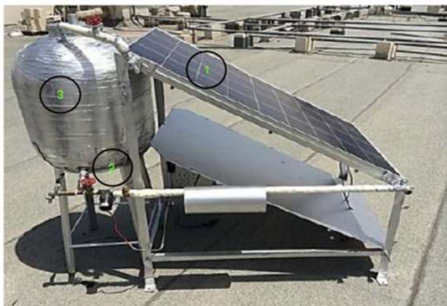
شکل ۲- ۱۱. روش استفاده از گردش اجباری آب در پشت ماژول به منظور خنک‌کاری [۴۰].
