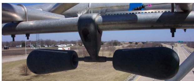
تصویر ۱-۶ - شکل نمادین و واقعی جاذب غیرفعال استوک بریج [1]
