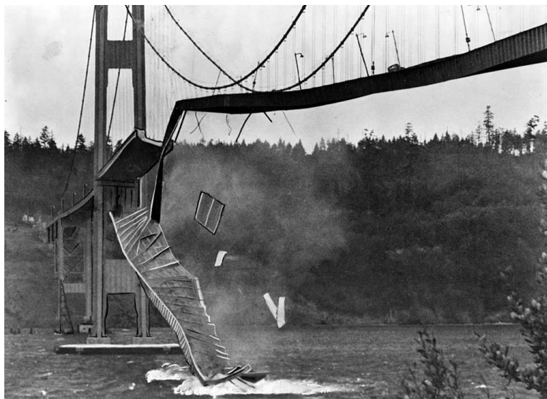
تصویر ۱-۱- پل تاکوما بعد از فروپاشی در اثر ارتعاشات ناشی از باد
