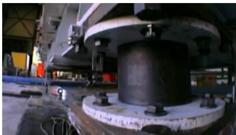
تصویر ۱-۴- پایه های جاذب ساخته شده برای پل گلدن گیت ۱
