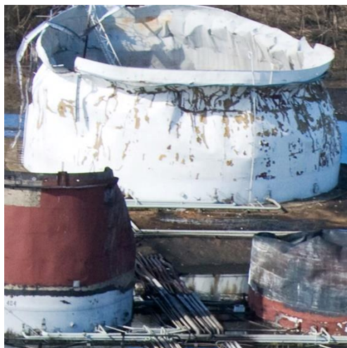
شکل (۱-۱) کمانش حرارتی مخزن استوانه‌ای ناشی از آتش‌سوزی [۱]
