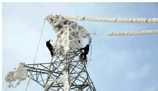
شکل ۱.۱: کابل‌های انتقال پوشیده‌شده از یخ
