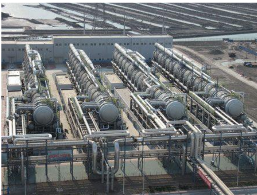
شکل ۱-۱۵: یک واحد آب شیرین کن MED در چین [۱۵]
