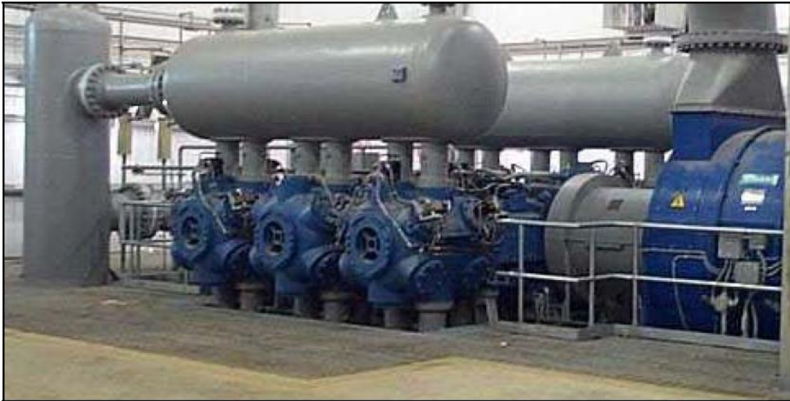
شکل ۱-۳- نسل سوم کمپرسورهای رفت و برگشتی مورد استفاده در صنعت گاز [۳]
